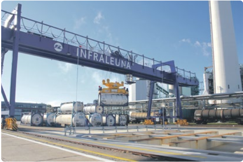
Das neue Container-Gefahrstofflager der InfraLeuna.
